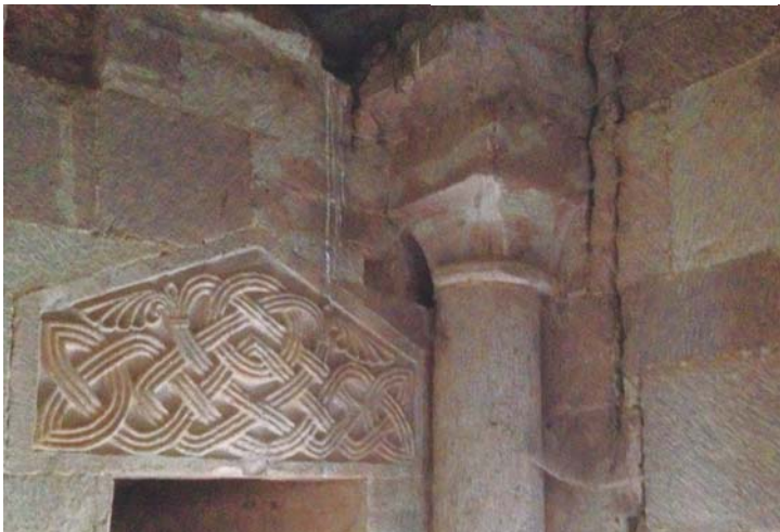
Eglise de Bessuéjols (GR 65)
